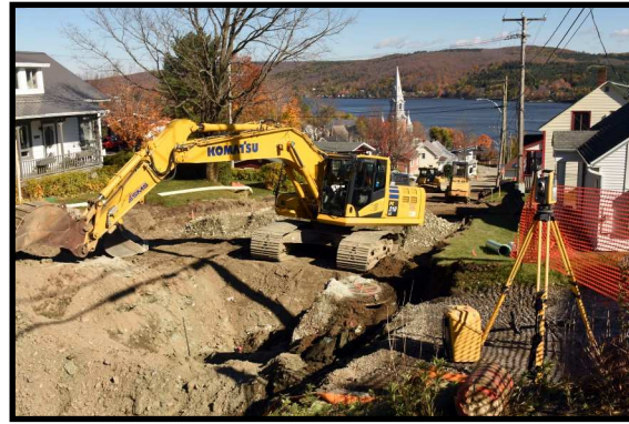
Travaux sur la Côte de l'Église
