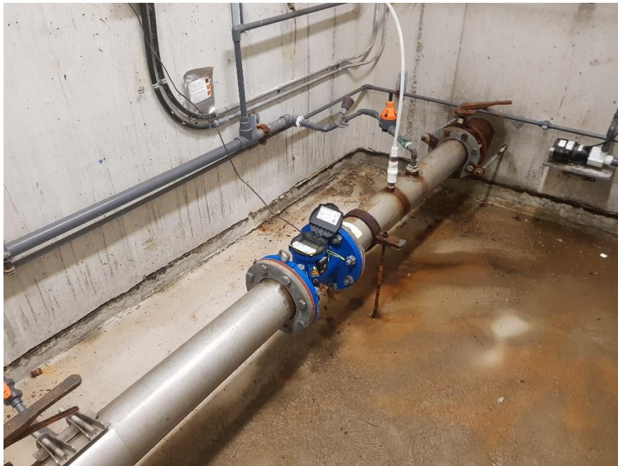
Photo 28 – Vue du système d'injection d'hypochlorite de sodium dans le réseau.
