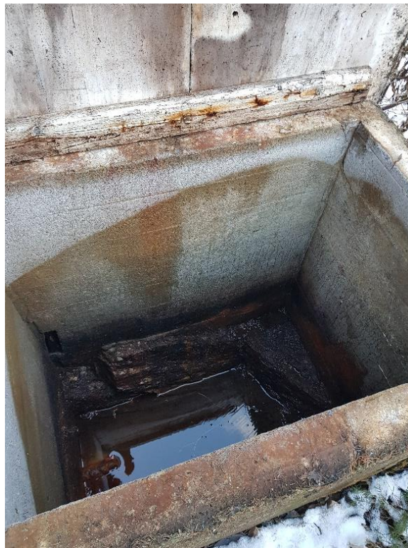
Photo 10 – Vue de l'intérieur du collecteur C-4.
