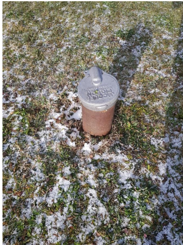
Photo 20 – Vue du puits du Garage.
