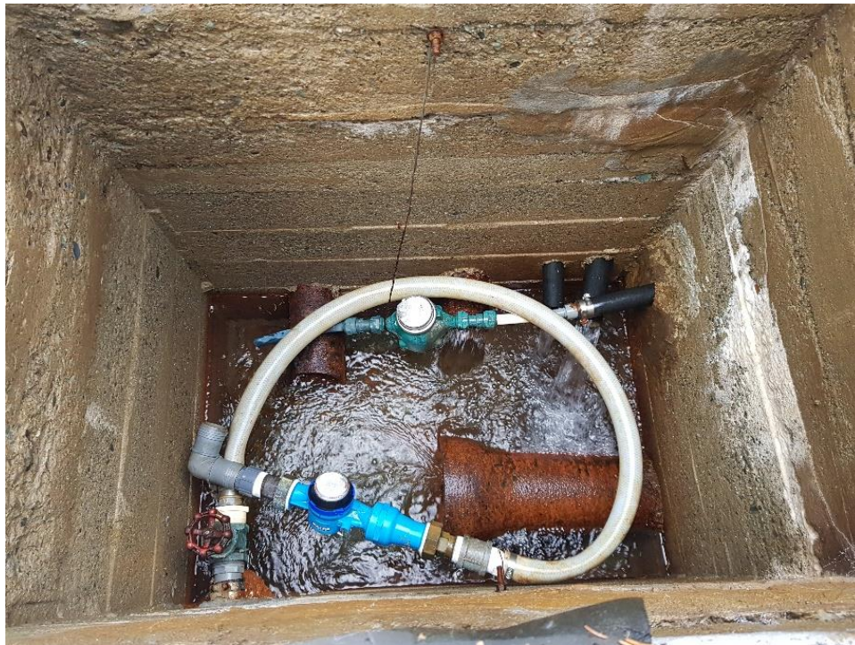
Photo 15 – Intérieur de la chambre de collecte des eaux des collecteurs C-1 à C-6 et du puits Gros Boissonneault.
