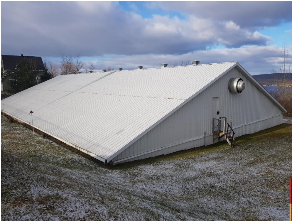
Photo 31 – Visée nord-ouest. Vue du réservoir en eau potable de la Municipalité de Saint-Ferdinand.
