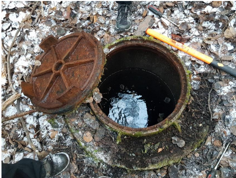
Photo 13 – Vue de l'intérieur du collecteur C-6.
