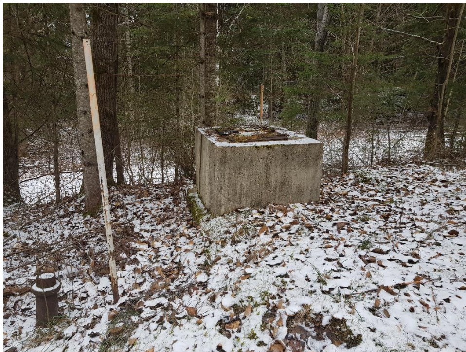
Photo 14 – Chambre de collecte des eaux des collecteurs C-1 à C-6 et du puits Gros Boissonneault.
