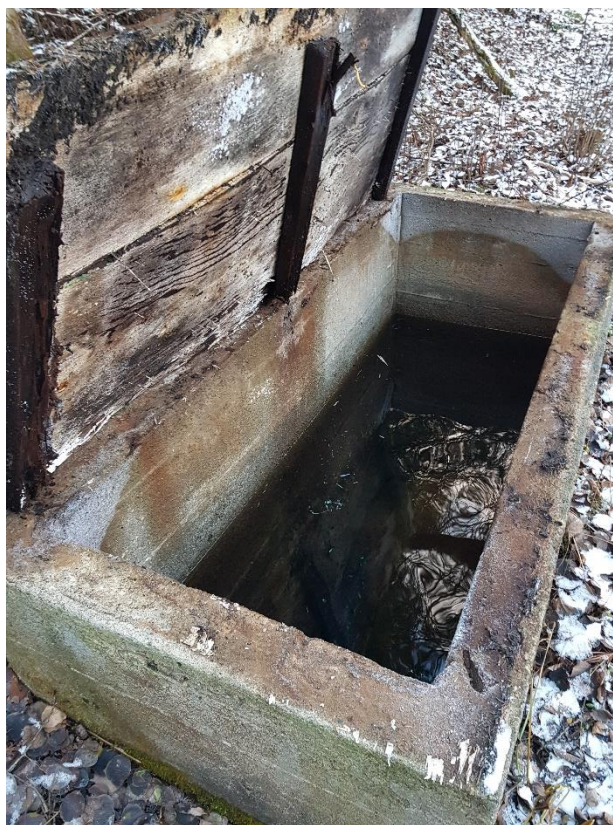
Photo 8 – Vue de l'intérieur du collecteur C-3.
