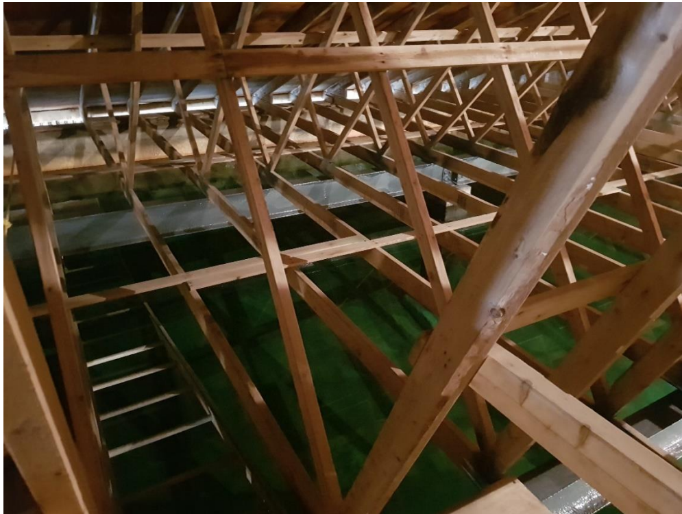
Photo 32 – Vue de l'intérieur du réservoir en eau potable de la Municipalité de Saint-Ferdinand.
