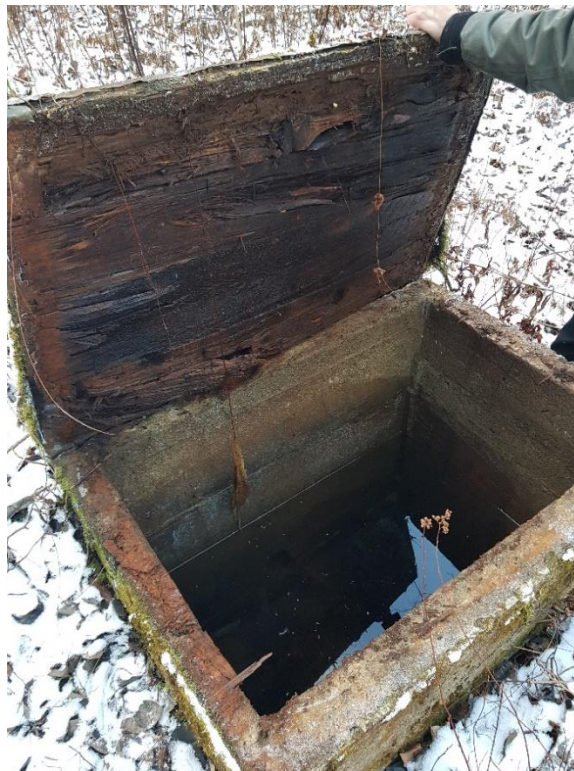
Photo 6 – Vue de l'intérieur du collecteur C-1.
