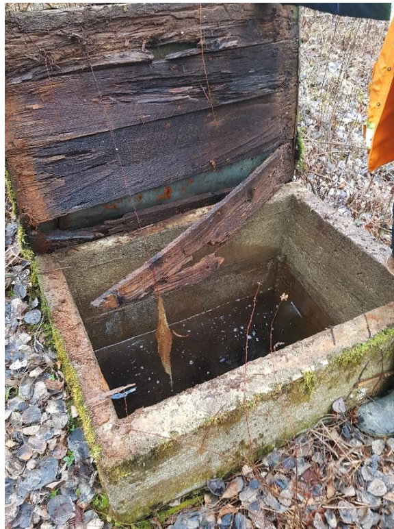
Photo 11 – Vue de l'intérieur du collecteur C-5.
